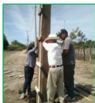
- El Hno. Socorro Reyes en Cibacobe, MX. quien ya construyó la mufa para la instalación eléctrica donde se construirá el templo para esta iglesia.
